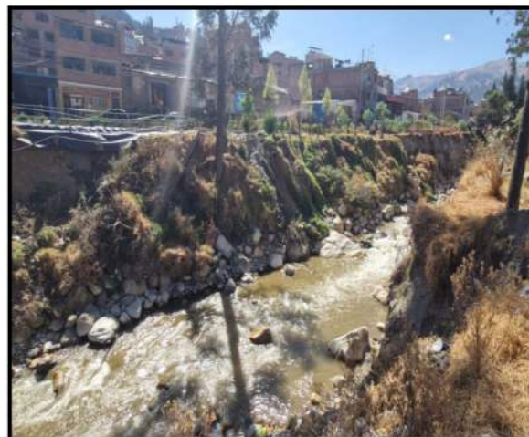
Fotografía 04: se muestra el Rio Calcayhuanca (Rio Auqui--Quillcay) que requieren de conformacion de bordo con material propio limpieza ante un evento extraordinario
